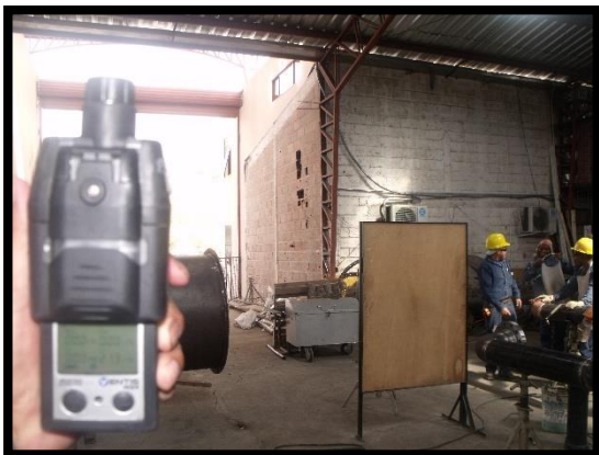
Área de soldadura
