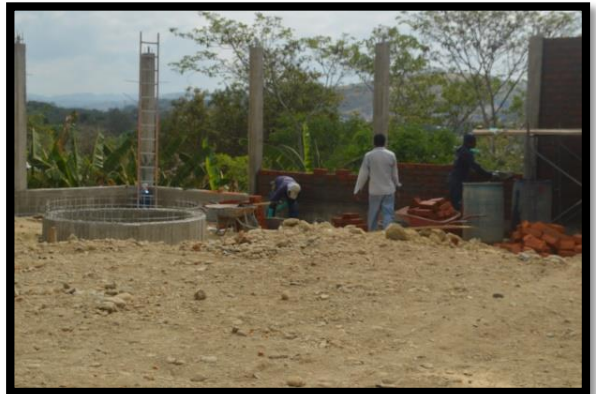
ARÉA EN CONSTRUCCIÓN
